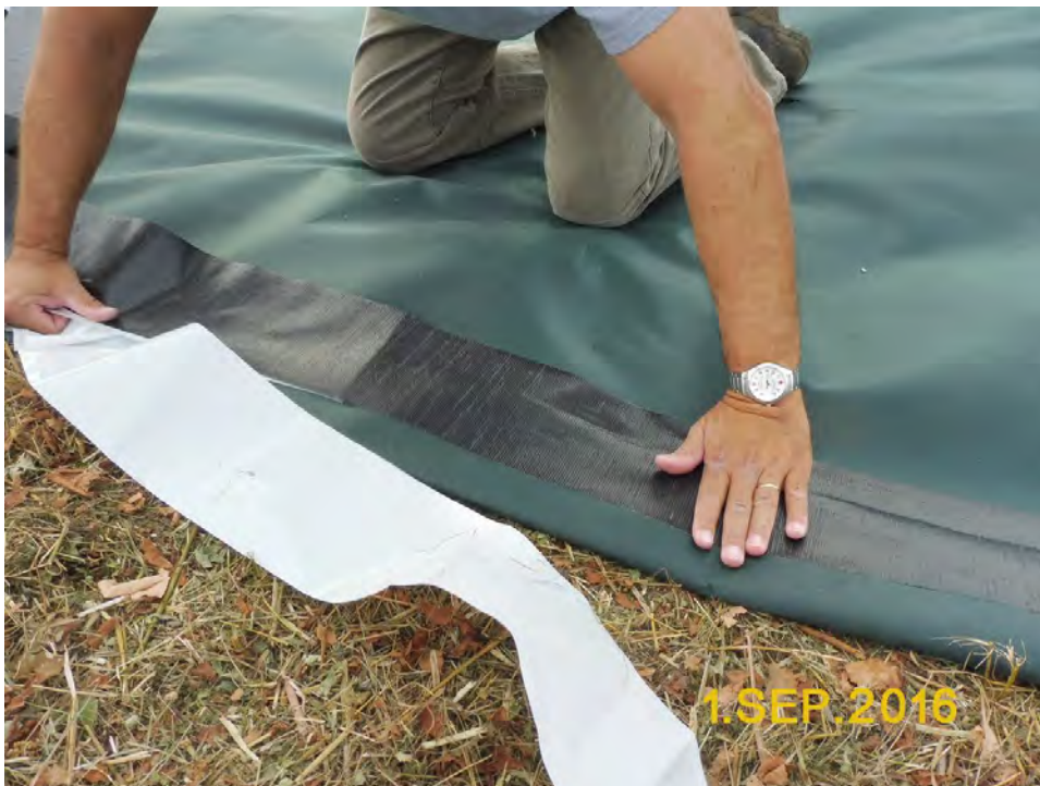
Bild 16: Mit dem Tape werden beide Bahnen verbunden
