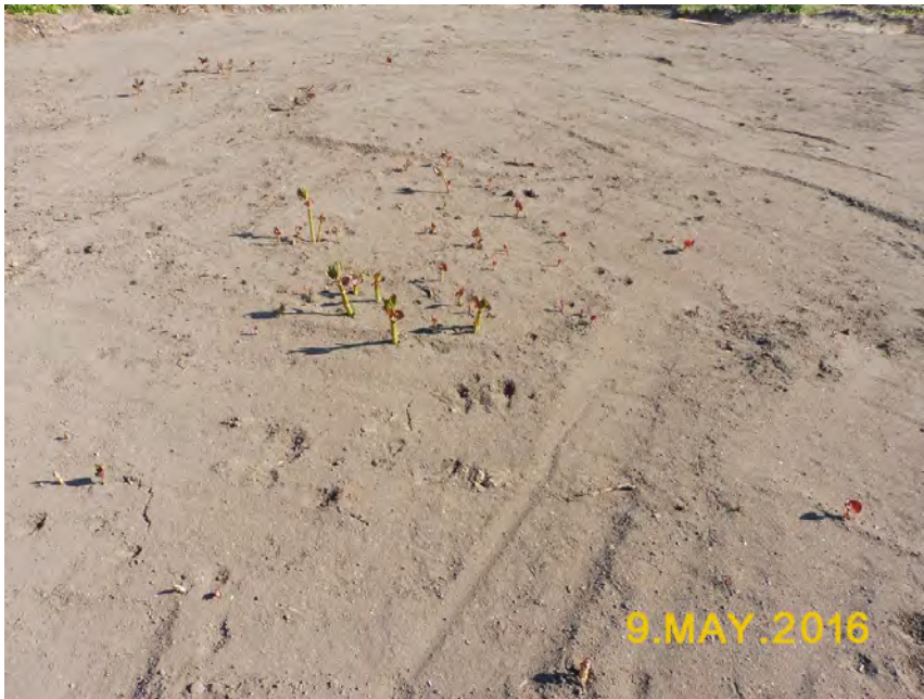
Bild 5: Durch das neue Planum treiben selbst die gefrästen Wurzeln nach kurzer Zeit unvermindert aus
