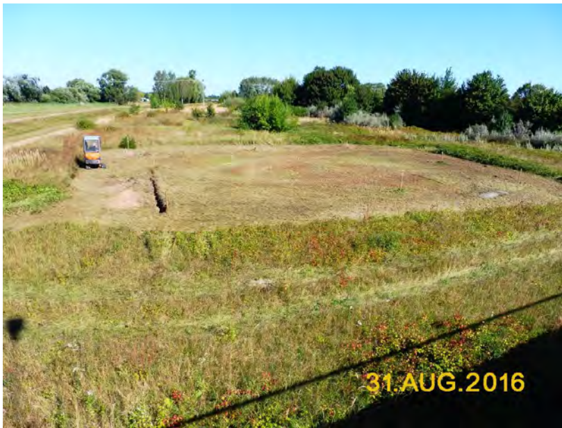
Bild 14: Herstellen eines Wurzelschutz- Grabens
