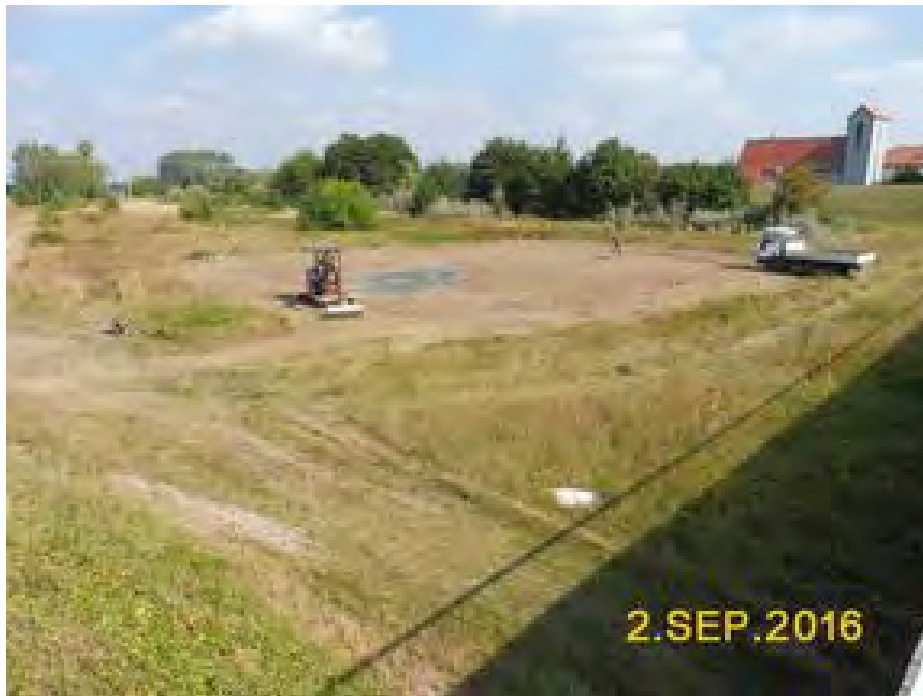
Bild 17: Zum Abschluss wird Boden aufgetragen
